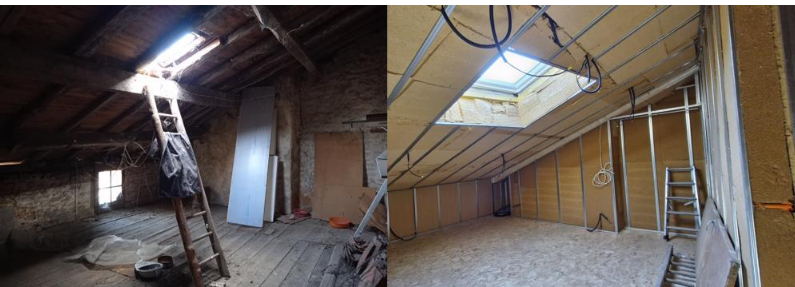
Avant les travaux / Après les travaux
